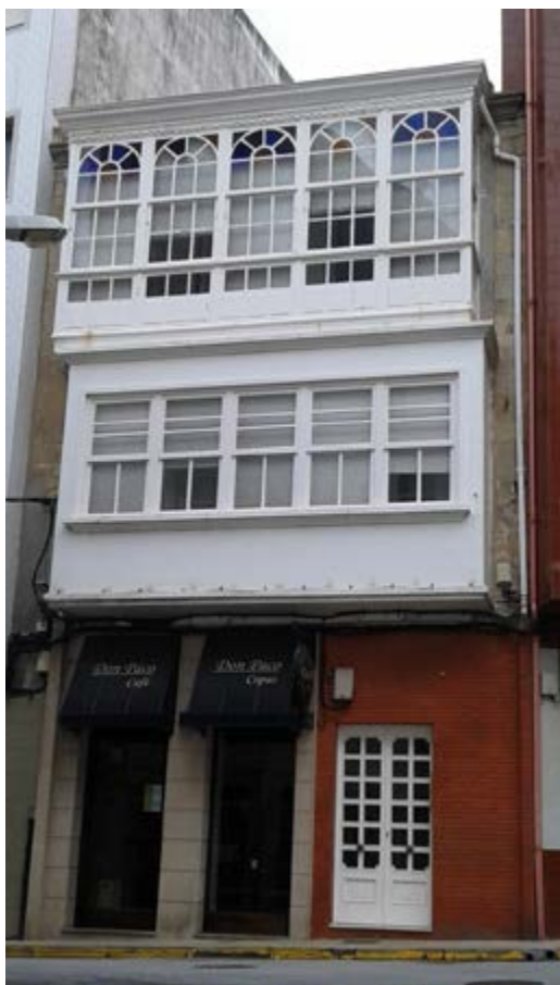
Casa de Anselmo Villar Amigo na rúa do Cruceiro de Malpica. (Fotografía do autor).
